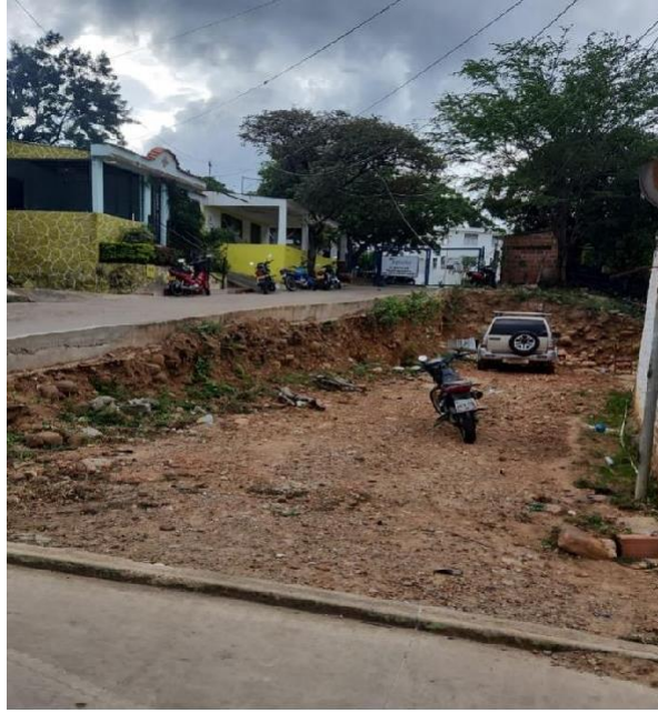
Tramo final conexión a la PTAP aun sin Instalación de Tubería
