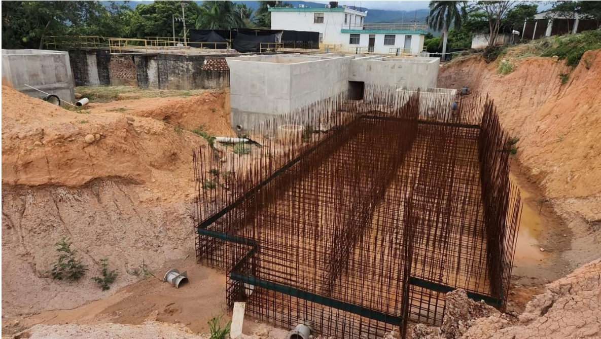
Estado de la Ampliación de la PTAP
