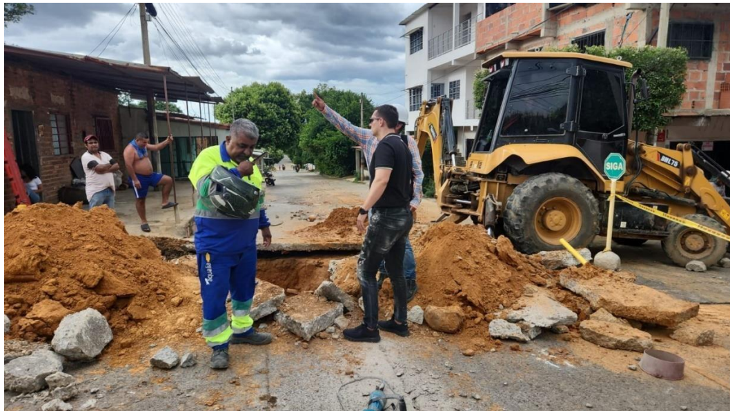
Instalación de Tubería en la línea de conducción Tramo 2
