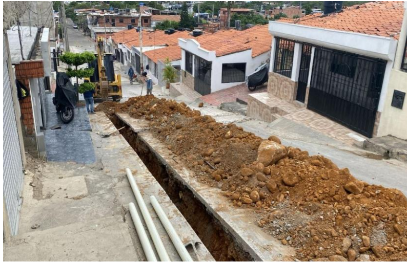
Ejecución Proyecto Barrio Los Trapiches
